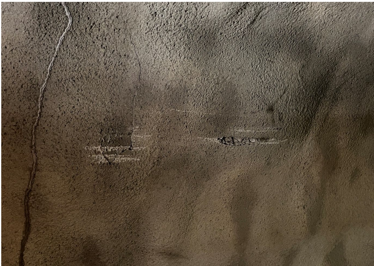
Figur 4: Skadet PE-skum ved pel. 170.
