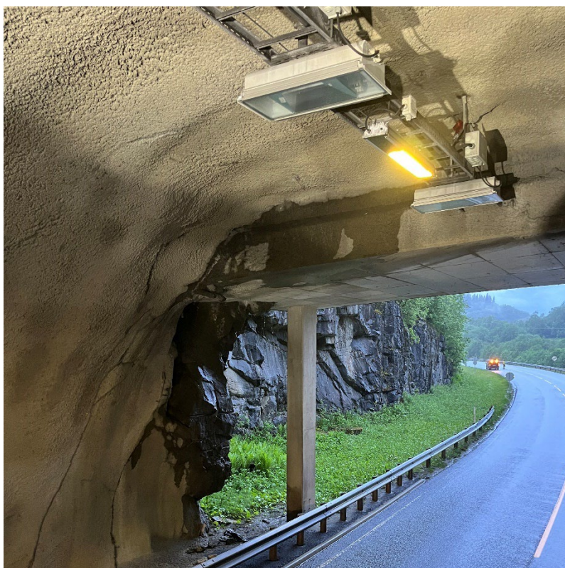
Figur 5: Fukt langs skjør portal i nord.
